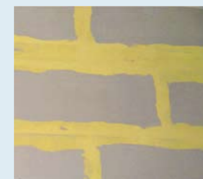
Фугирање со Safeboardspachtel за најголема сигурност
